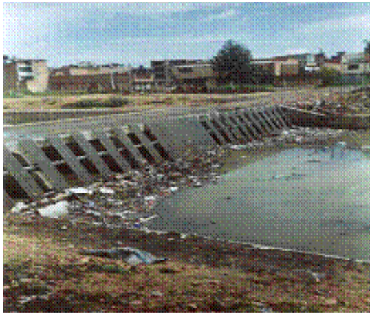
Figura 7.21 Estructura de retención de sólidos. Fuente ADESSA
