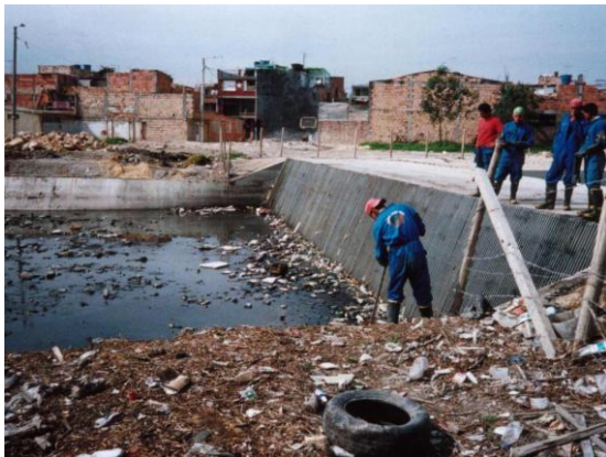
Figura 7.23 Construcción de las rejillas de la estructura de retención de sólidos de la calle 105D. Fuente ADESSA
