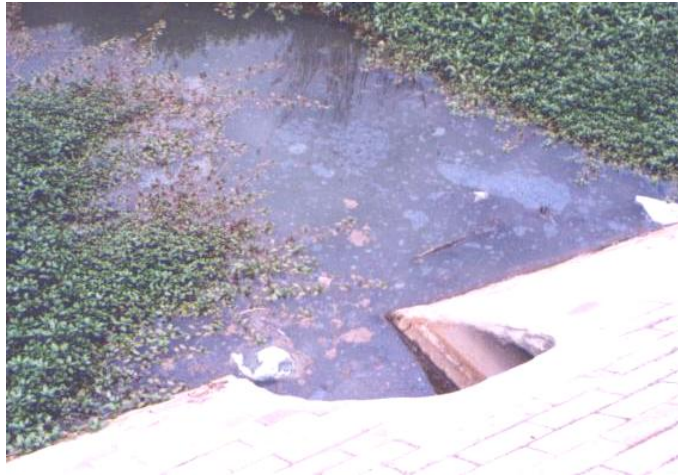
Figura 7.2 Se observa la salida de manchas de aceites en este desagüe. Fuente: ADESSA
