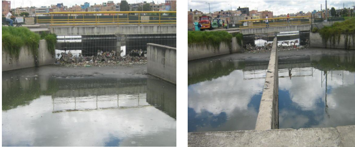
Figura 1.19 Rejillas de la estructura de retención de sólidos y tanques sedimentadores. Fuente ADESSA 2004
