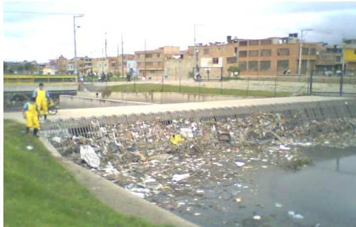
Figura 7.8 Problema de basuras rejillas de la estructura de sólidos. Fuente ADESSA
