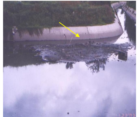
Figura 7.10 A lo largo de los canales se encuentran acumulaciones de lodos que interrumpen el flujo de las aguas. Fuente ADESSA.
